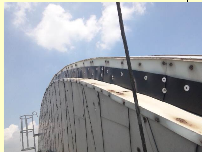
防水ゴムを取り替えました
