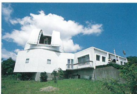
太陽観測専用に作られた望遠鏡。太陽の強い光を反射するように酸化チタンの塗料をぬってある。自動追尾装置によって太陽観測が完全自動化されている。
