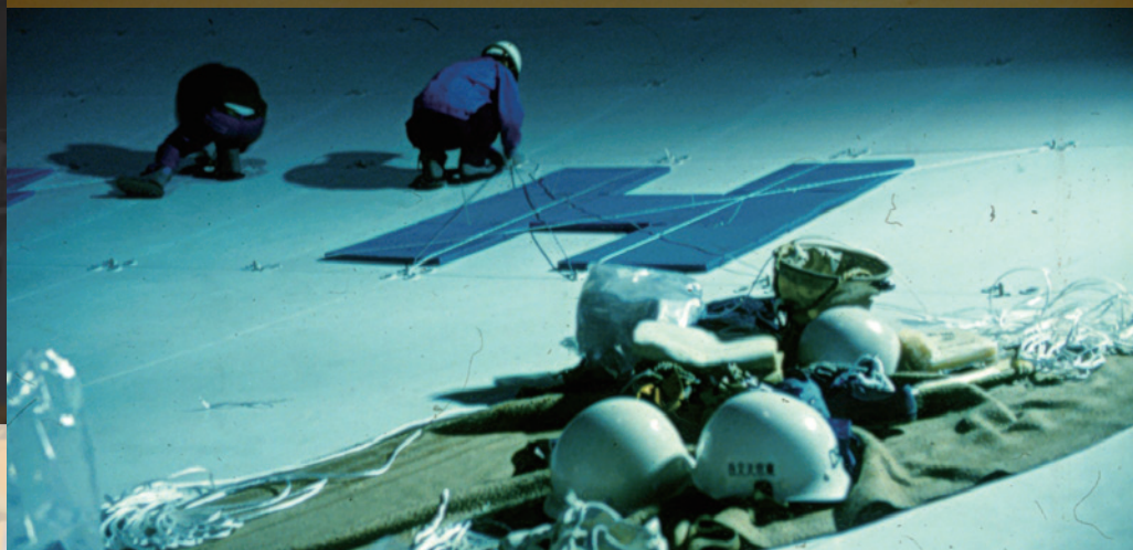
1986年、45mミリ波望遠鏡上で、ホログラフィ測定校正用の電波吸収体取り付け作業。日暮後で暗いにもかかわらず作業いただいている。このメーカーの方々には、およそ40年前の当時からお世話になってきた。
