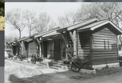
図2 三鷹キャンパスにあった連合子午儀。手前に写る建屋内部に、図1の台座に載った背景写真のバンベルヒ子午儀が収まっていた。
