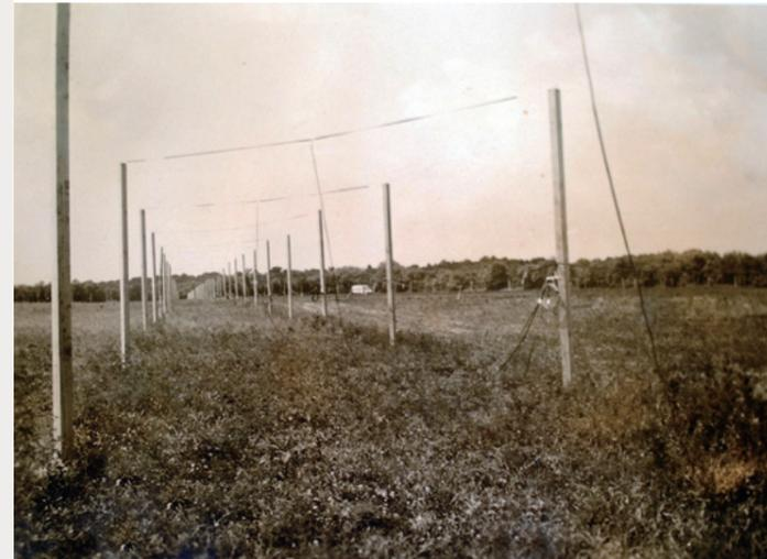
図01 オーストラリアの電波天文学者であるミルズ (B. Y. Mills) と後に干渉計の開口合成でノーベル賞を受賞したイギリスのライル (Martin Ryle) が設計したアンテナで、66対の木製のマスト上端に電線を張ったものだ。使われた電線は総延長8kmにもなったという。受信機器は、もともと現場に置かれていた陸軍の余剰トラックに載せられていた。残念ながら現在は撤去され、観測所もアンテナも残っていない。
