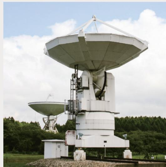
図12 大阪府立大学電波天文学研究室が使用していた野辺山宇宙電波観測所のミリ波干渉計F号機。ミリ波干渉計は口径10 mパラボラアンテナを6基で観測を行っていましたが、運用終了後にF号機だけを単独で使用できるように改修して活用されてきました。後ろに見えるのは野辺山45 m電波望遠鏡です。
