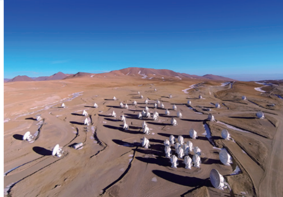
(左) チリの標高5000mの高原で運用されている、アルマ望遠鏡。口径12mアンテナ54台と口径7mアンテナ12台を組み合わせ、巨大な電波望遠鏡として機能します。Credit: ALMA (ESO/NAOJ/NRAO), A. Marinkovic/X Cam
