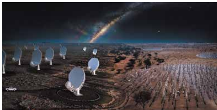
図02 SKAの構成イメージ図 南アフリカに199台のパラボラアンテナ、オーストラリアに512の低周波数アンテナステーションで構成される。(クレジット: SKA Observatory https://www.skatelescope.org/news/skao-is-born/ )
