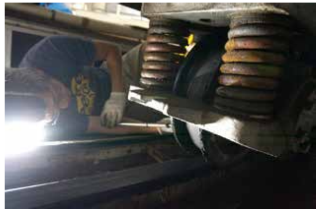
02 ドーム旋回台車(計48台)への注油作業。横になった苦しい体勢での作業。
