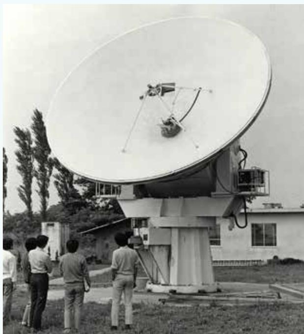
図03 完成した6mミリ波望遠鏡（向こう側が観測棟）。
