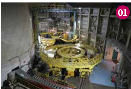
ドーム1Fに設置・保管している蒸着関連装置。蒸着直前に試運転を行いました。
