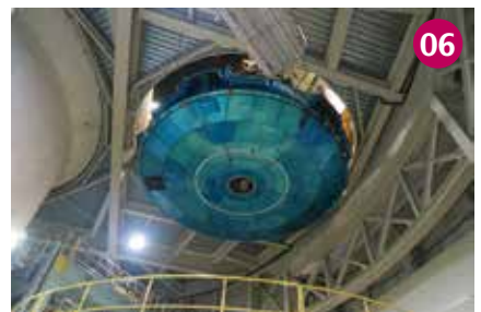
主鏡と望遠鏡の一部(主鏡セル)を慎重にドーム1Fに輸送します。
