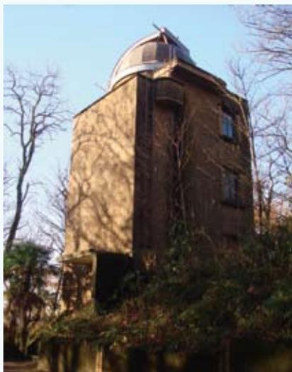
5階の塔上のドームには2枚の平面鏡を用いたシーロスタットがあり、塔が望遠鏡の筒になっている。購入時はシーロスタットの直下に対物レンズがある屈折望遠鏡であった。この焦点距離1442cmのレンズも健在である。
