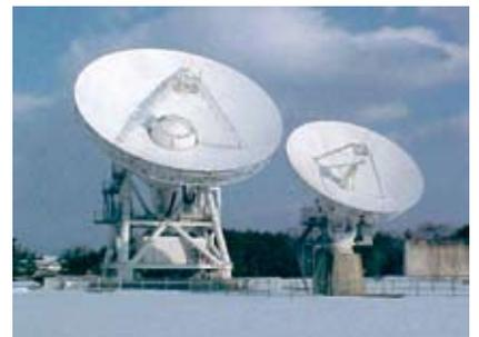
図4 水沢局のVERAの20m鏡(左)と、10m電波望遠鏡(右)。この2台のアンテナを使って雑音源法の精度が実証されました。VERAのアンテナの鏡面中央にある膨らみがフィードームで、それを支持する台座の周囲に4か所の雑音源が設置されています。
