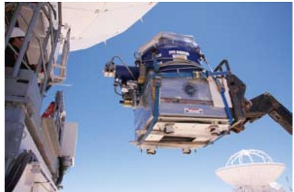
▲写真2 アンテナへの受信機フロントエンドの搭載作業
