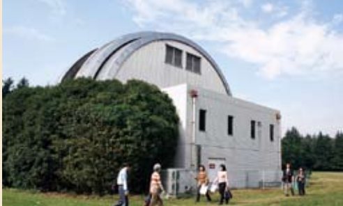
▲カマボコ型ドームをもつ旧 PMC 棟が観測ターゲット。
