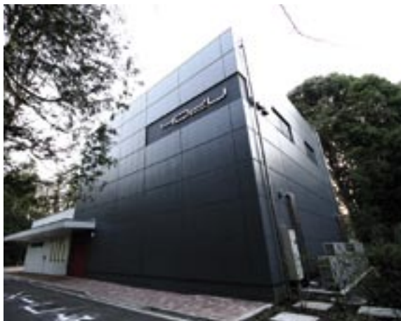
▲ 4D2U ドームシアター棟の外観
