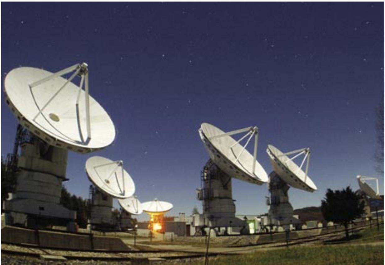
図3 野辺山レインボー干渉計は、口径10mのアンテナ6台からなる野辺山ミリ波干渉計(NMA)に、口径45mのミリ波望遠鏡(写真中央奥)をつないだ干渉計システムです。計7台のアンテナで高い性能を得られることから「レインボー干渉計」と名づけられました。NMAの高い解像度と45m鏡の高い集光力の二つの性能を同時に実現できる装置です。(NMAの紹介記事が16ページにありますので、ご覧下さい)。
