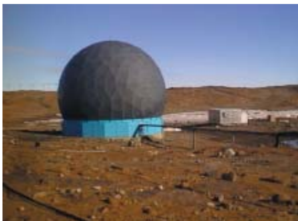
図1：昭和基地の多目的衛星受信アンテナが入っているレドーム。
