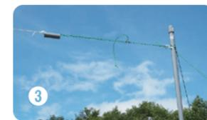
③アンテナエレメント先端は、穴を開けた短い塩ビパイプに結束バンド2本で固定している。さらに、自在金具を入れた張り綱をアンテナマストの上部に付けた金具に通して、エレメントをできるだけ地面と平行になるように張っている。マストの張り綱は、張り綱そのものを結んで輪を作り、マスト先端に引っかけているだけ。
