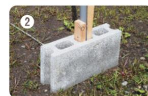
②アンテナマストの基礎は、安価な空洞コンクリートブロックを流用した。アンテナマスト本体となる塩ビパイプを穴に刺して、細い木の棒で隙間を埋めるといった単純な構造だ。
