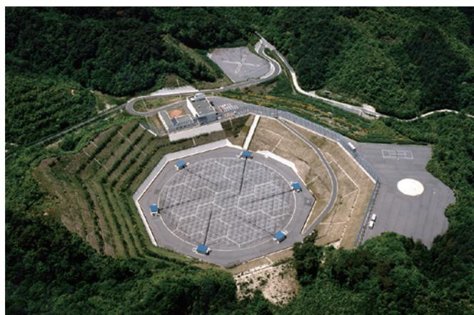
図28 直径103mの円の中に整然と並べられた475本のアンテナ。空のあらゆる方向へ位相をそろえた電波を送信するだけでなく、1秒間に2500回という高速で電波の方向を変えることができる。
