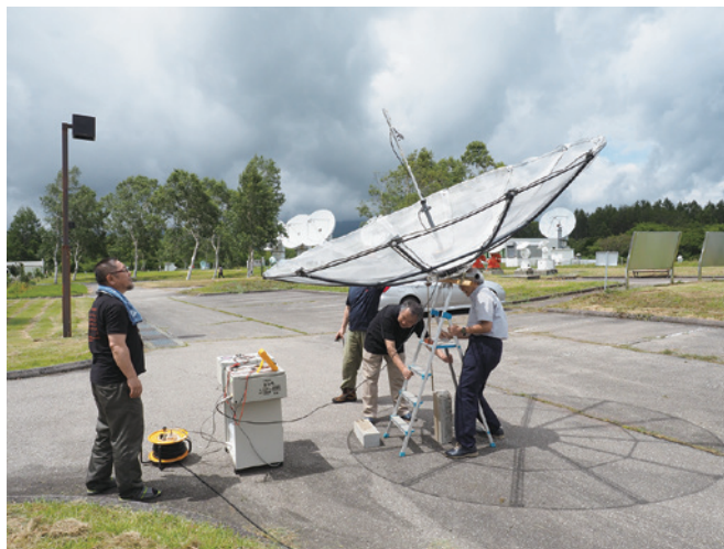
図05 これでパラボラアンテナの完成だ！
