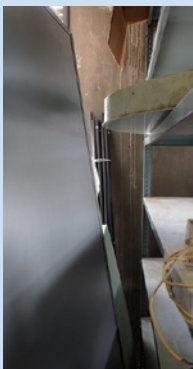
02 さまざまな機器や資材の奥に、チャリと見えたパイプの束。パラボラの骨組み「ハッケン!!!」。
