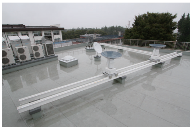
図01 建築されてから間もない情報技術科棟の屋上には、最初から電波干渉計用としてのレールを載せる台座が組み付けられていて、すでにレールは完成済み。設置は駒ヶ根工業高校にゆかりのある鉄工所が行った。レールは東西に15m、南北に11mの長さ。高さは0.1mm以内の精度で水平に固定されているという。
