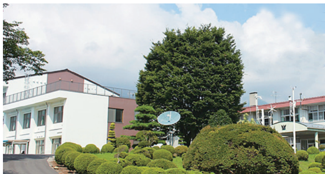
図01 南アルプスと中央アルプスを望む自然豊かな地域にある駒ヶ根工業高校。校舎正面玄関前には太陽電波望遠鏡が堂々と建っている。4素子の太陽電波干渉計は、左後ろの情報技術科棟の屋上に設置が進行中。
