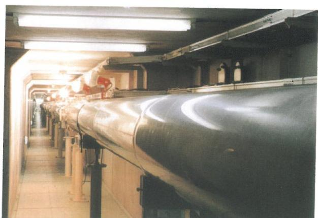
図 1 全長 300 m の真空パイプ。地下通路に配置され、この中をレーザービームが往復する。これが 2 本直交してマイケルソン干渉計の腕を構成する。
