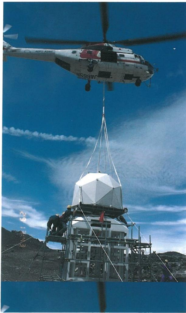
図3 ヘリコプターで設置される富士山頂サブミリ波望遠鏡
