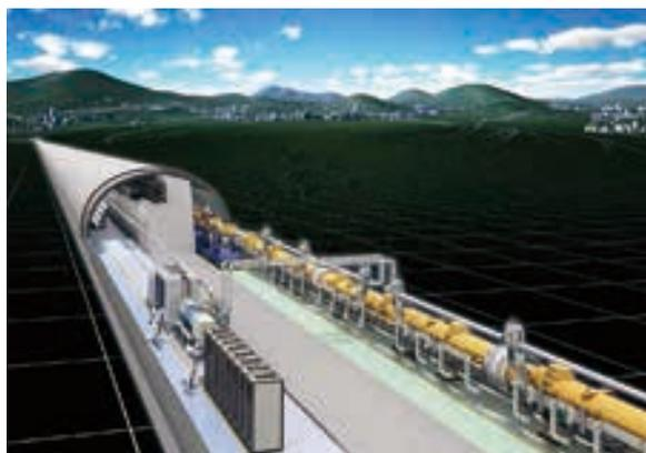
国際リニアコライダー（ILC）計画。長さ30キロメートルの直線のトンネルの中で電子・陽電子を超高速に加速し、宇宙初期にしか生成しない多くの粒子を生成・検出することで、ダークマターを含む新物理仮説に迫ります。建設候補地は、東北地方の北上山地が最も有力視されています。
