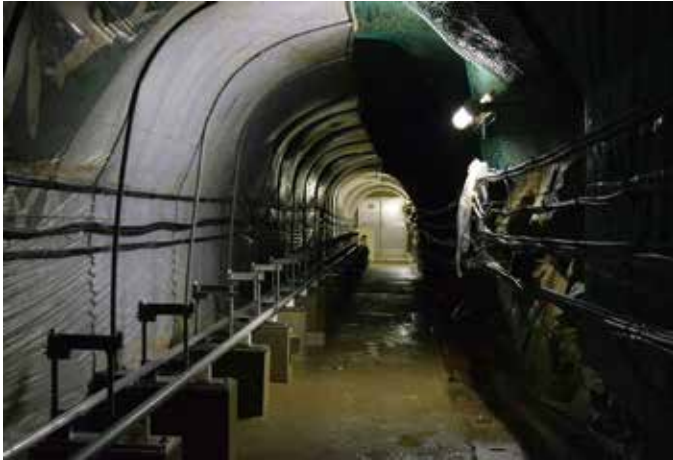
図01 江刺施設の坑道の様子。
