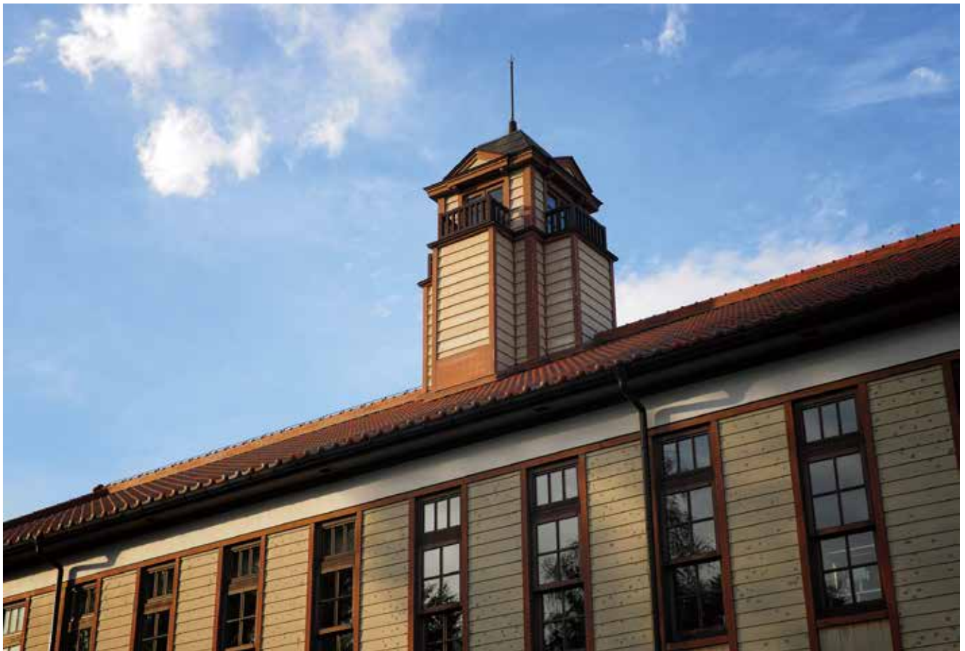
水沢観測所の旧本館。今は奥州宇宙遊学館として多くの見学者で賑わっています（撮影：飯島 裕）。
