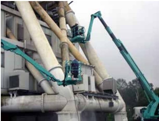
高所作業車による架台の洗浄作業。
