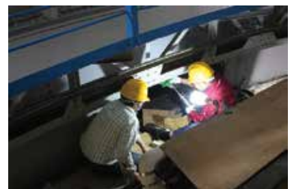
図07 ドーム車輪への注油作業。
