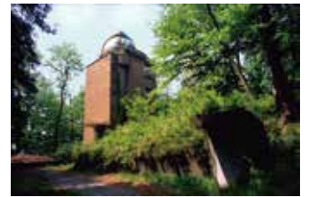
図03 塔望遠鏡。手前が半地下の大分光器室。
