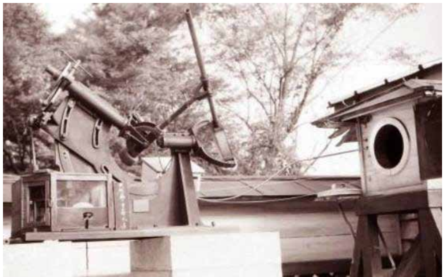
図02 稼働中のグラブ社サイデロスタット。中央にあるのが反射鏡で、太陽光を右側の丸穴に導いている。
