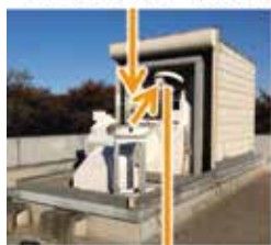
ヘリオスタット(ATC屋上)
