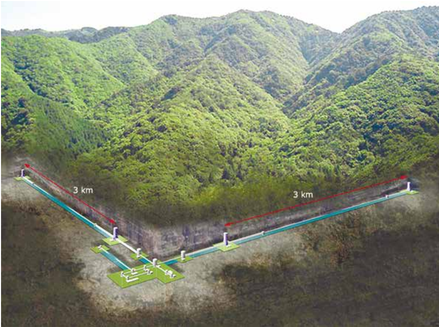
図1 岐阜県神岡町池ノ山地下に建設中の基線長3kmの重力波検出器KAGRA。
