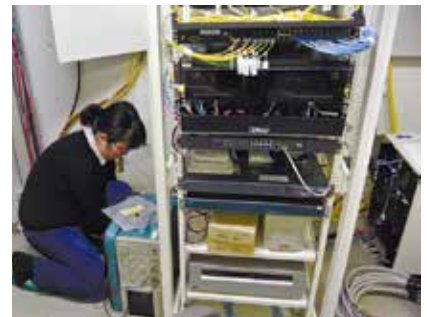
図2 神岡のネットワーク開通作業をする福井麻美さん(データセンター)。
