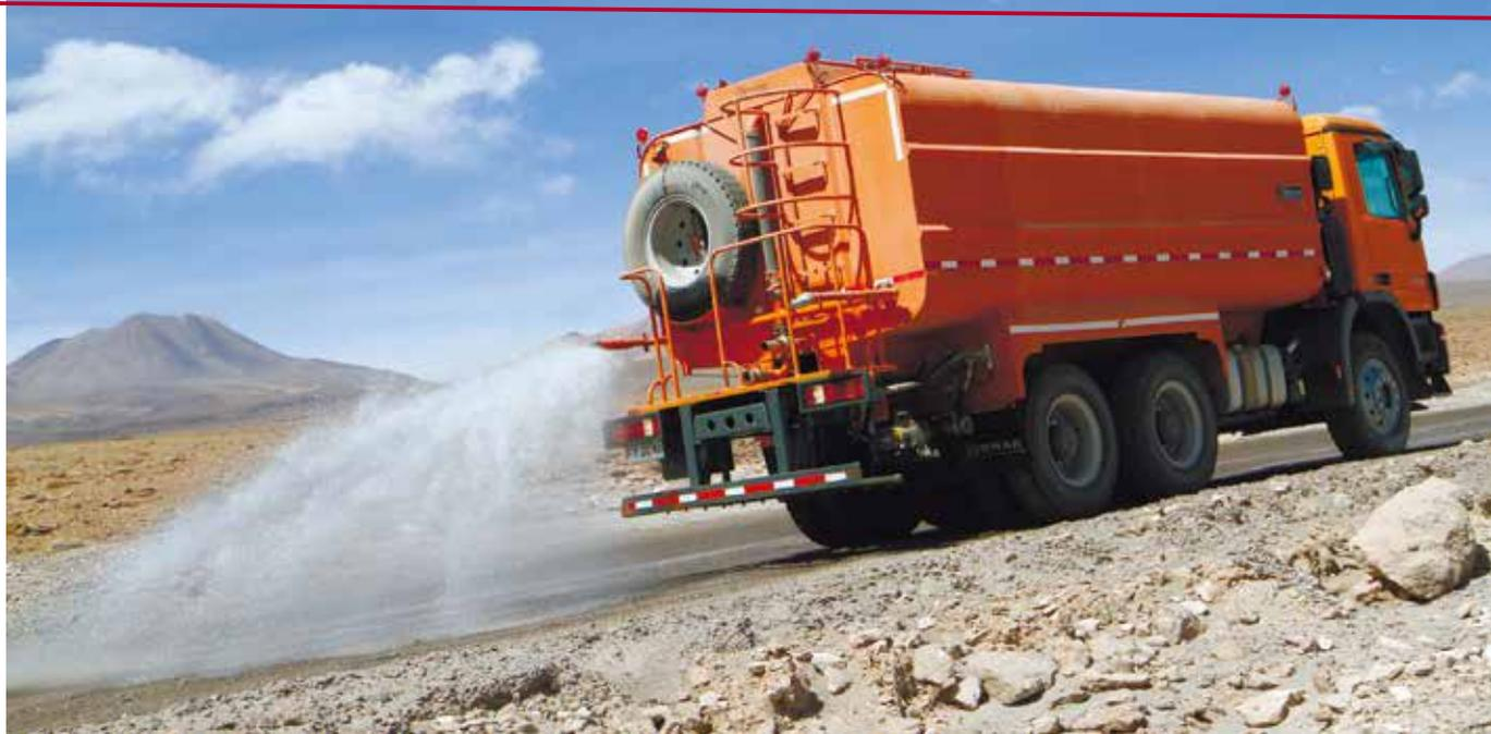
観測所ゲートから山頂施設まで40kmの道路は「塩舗装」されている。土に塩と水を混ぜてローラーでならしたもので、時折、散水車で水をまいて厳しい乾燥による劣化を防止する。
