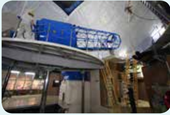
▲主鏡・副鏡を取り出すために、望遠鏡に付属している各種装置・部材を取り外す必要がある。解体のためにはまず、望遠鏡を横倒しにし、固定する作業から開始する。
