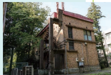
スクラッチタイルの外壁が美しい旧図庫。
