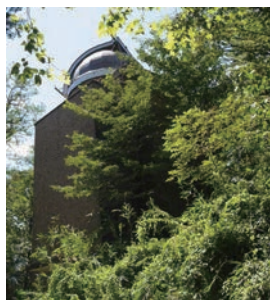
太陽塔望遠鏡の塔部分を北東から仰ぎ見たところ。
