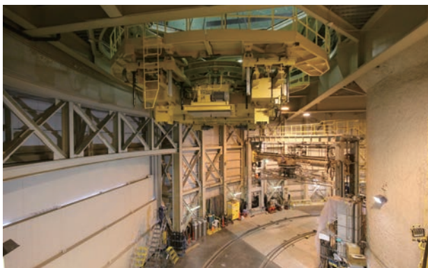
図07 台車を1階から望遠鏡階(カセグレン床)に吊り上げるところ。1階天井付近を上昇中。車輪がレールに沿って平行、望遠鏡ピア(右側)に対しても平行。
