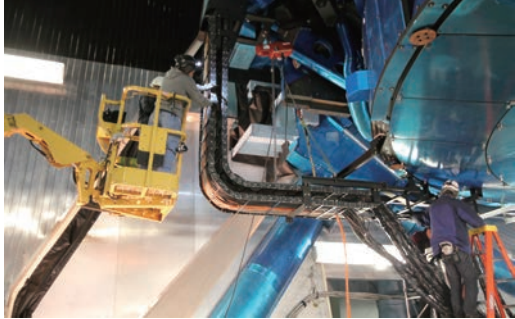
図04 はずしたケーブルの取り回し。ケーブルの取り回しは、かなり力のある手作業中だ。
