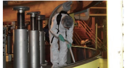
図18 蒸着装置内部の清掃中。きれいな鏡面は、きれいな蒸着装置から。
