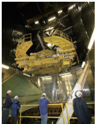
図08 クレーンに吊られた台車を引き続き床上10mぐらいいまで上げ、ハッチを閉める。ハッチが閉まったら、その上に台車を下ろす。車輪が90度回転して、望遠鏡に対して直交となる。
