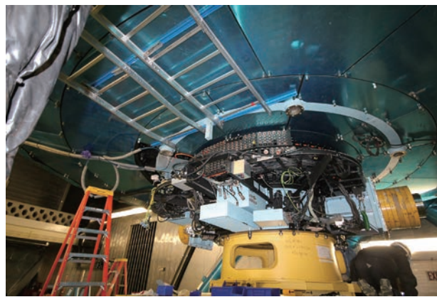
図02 AO層とケーブル巻き取り層のようす。まず、第1世代の補償光学装置(AO)が付いていた層を取り外してカートに載せようとしているところ。
