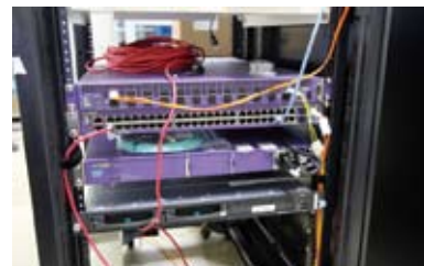
05 10GbEのエッジスイッチ（写真最上段：ネットワーク末端で外部の回線や端末などの接続に用いられるもの）。
