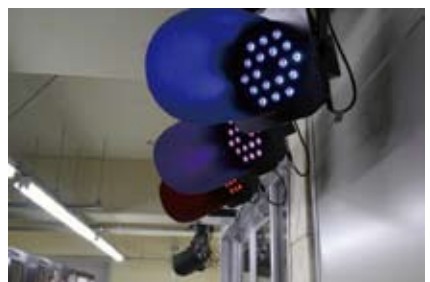
03 多色照明システム。舞台用のLED照明を使用しており、その無制限色調再現は、カラフルなアテルイの姿を作り出す。
