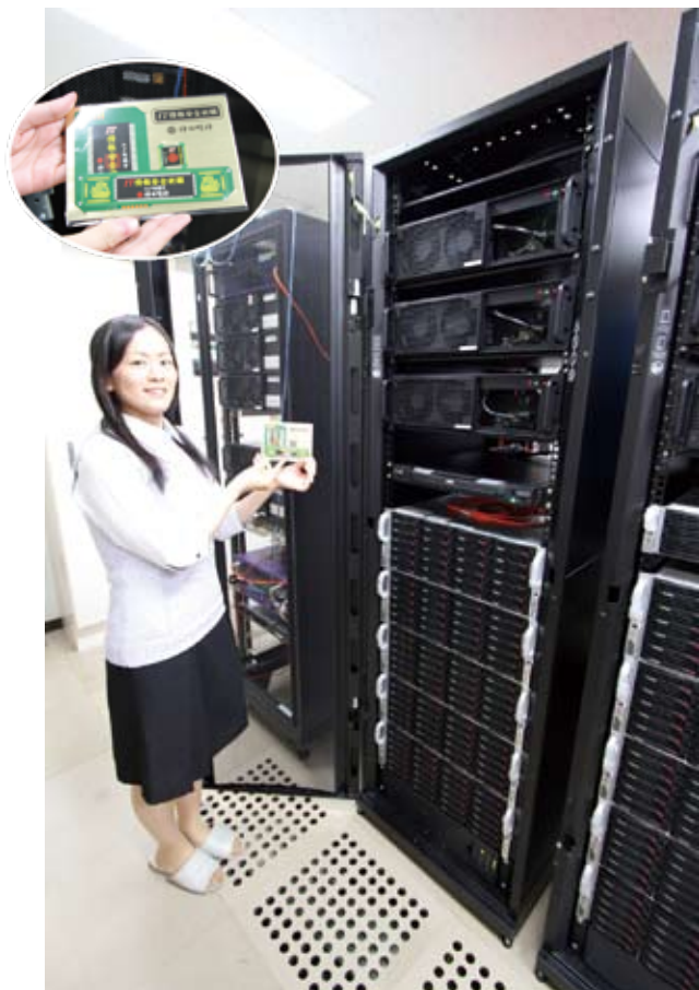
01 解析サーバ（ラック上）とファイルサーバ（ラック下）。スタッフの木村さんが手にしているのは、サーバに実装されている神田明神ITお守り（左上は、その拡大画像）。
