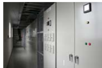
10 変電設備棟の内部。電力会社の送電線がこの建物に引き込まれ、変電された後、スパコン棟に供給される。
