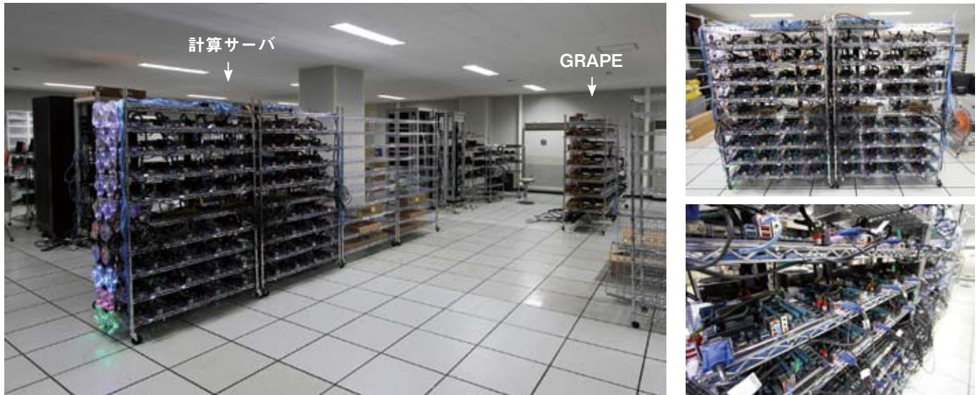
01 (左上) CfCA 計算機室。左手前が計算サーバ。GRAPE (16ページ参照) も同じ部屋に設置されている (右奥のラック)。運用を終えたCray XT4システムや NEC SX-9システムが撤去され、新たにGRAPEを設置。/ 02 (右上) メタルラックに並ぶ、むき出しの計算サーバ。空冷式のため、ケースレスにして冷却効率を向上させた。/ 03 (右) むき出し効果その2。各種ケーブルの取り回しやアクセスがしやすく、計算サーバの増築・改修も容易。
