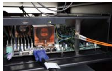
04 解析サーバに接続される光ケーブル（オレンジの配線）。各解析サーバ、ファイルサーバは10GbEの高速回線で結ばれている。
