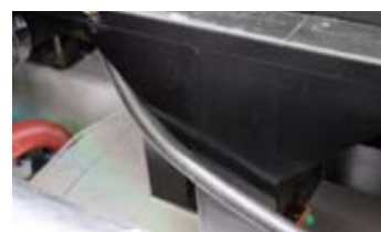
07 スパコンルームの床はフリーアクセスだが、アテルイの重量を支えるために鉄製の台座が床下に設置された。
