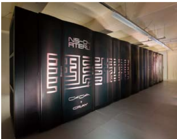
01 アテルイ本体。アテルイが納められているスーパーコンピュータ室は、観測機器棟を改修したものです。
