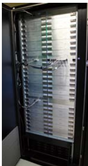
02 アテルイのフロントパネルを開けた状態。一つのキャビネットには、CPUが納められているボックス（ブレード）が左右24台ずつ、計48台が搭載されている。
