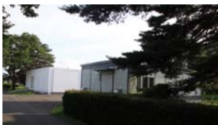
11 スーパーコンピュータ室（奥）とスパコン電気室（手前）。スパコン棟の灰色の扉が搬入口。正規の入り口は写真の向こう側にある。
