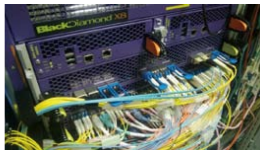
アテルイを接続するネットワーク機器（上）と基幹ネットワーク機器（下）。
