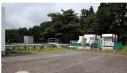
12 スパコンは水冷式で、循環水の冷却システムは屋外に設置されている。水沢観測所初代所長 木村榮がZ項を発見した眼鏡天頂儀室（24ページ参照）とその水平決めに使用する目標台の間の空間を妨げないように、水冷システムはスパコン室から離れた場所に設置された。
