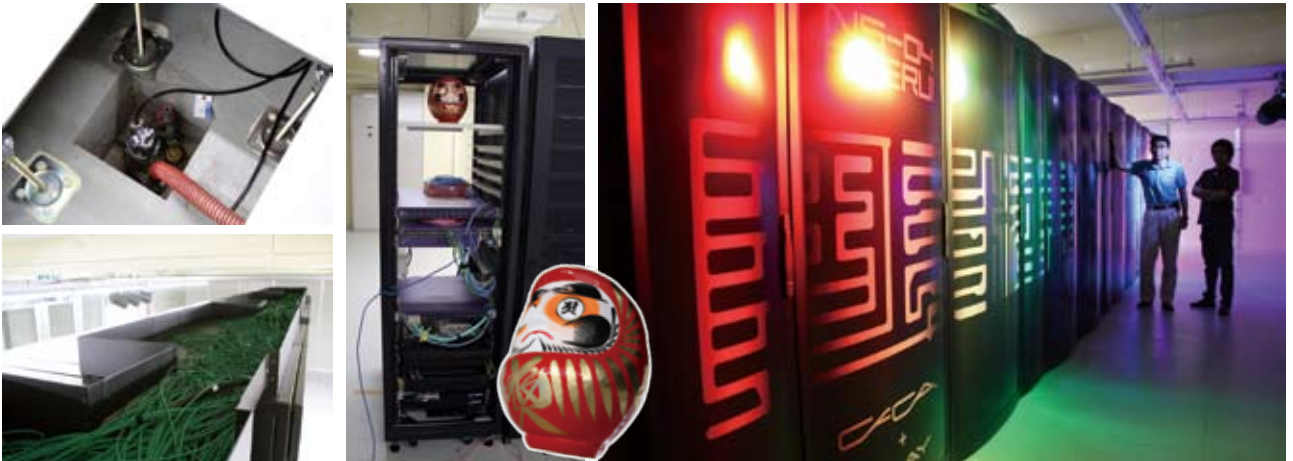
17 (左上) 冷却水が漏れた場合、床下に掘られた穴に水がたまる仕組みになっている。穴に一定量の水が溜まると、フロートスイッチが入りポンプで排水される。/18 (左下) アテルイのキャビネット上部を覗くと、所狭しと張り巡らされている光ファイバーの束を見ることができる。まるで緑色蕎麦の盛り。/19 (中) 10Gbイーサネットスイッチと安定運用祈願のダルマ。10Gbイーサネットについては、17ページを参照。/20 (右) アテルイを管理・運用するCfCAの水沢スタッフ。左が石川利昭さん(22ページ参照)、右が清水上 誠さん。
