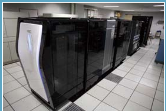
写真12 2008年4月に三鷹地区に導入された新しいスーパーコンピュータシステムの一部を成す日本電気SX-9。天文総合情報棟一階にあるスーパーコンピュータ室に設置された。
