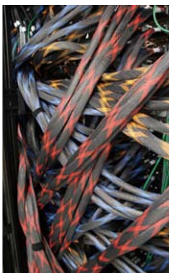
06 幾重にも張り巡らされたインターコネクは、まるで筋肉のようだ。ケーブルだけでも相当な重量となる。
