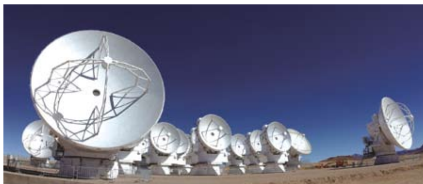
設置が完了したACAの16台のパラボラアンテナ。大きい12mアンテナと小ぶりな7mアンテナが密集して設置されている。Credit: ALMA (ESO/NAOJ/NRAO)
