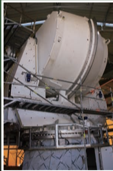
▲(左) ヨーロッパのアンテナ組立エリアでは、組み立て途中の7台のアンテナが公開された。普段でもヨーロッパの関係者以外は立ち入る事のできない場所の公開に、日本の関係者も興味津々。 ▲(中) 普段はコンテナ建屋に囲われて見ることができない建設途中のアンテナの稼働部分。土台の扉も開放され、中をのぞく事もできた。 ▲(右) 組立途中の12mアンテナ。パネル面の仕上げ加工やパネルの設置作業が行われていた。
