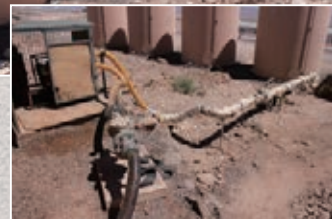
▲ OSF は最寄りの町「サンベドロ・デ・アタカマ」から約40km 離れている。そのため、OSF には電気・ガソリン・水などの独立したインフラ設備が整えられている。軽油やガソリン、水などは毎日タンクローリーで運ばれ、貯蔵される。写真左上は発電設備、左下はガソリンスタンド、右上は貯水タンク、右下は給水車からタンクに水を入れる為のポンプ設備。温水などは、宿泊施設の屋根などに設置された太陽熱温水システムでつくられている（写真中央）。
