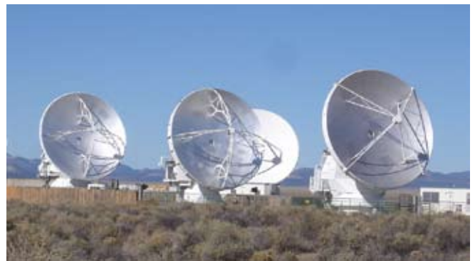
写真2 アメリカ・ニューメキシコ州のVLAサイトに並んだ3種類のプロトタイプアンテナ。左から日、米、欧の各アンテナ。
