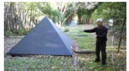
菱形基線の端点には測地基準点がおかれ、ピラミッド状のカバーで覆われています。基線尺比較室は筒口3m、長さ30mの細長い建物で、この地にありましたが、現在はその基礎と測定器が置かれた御影石の柱が残るのみです。
