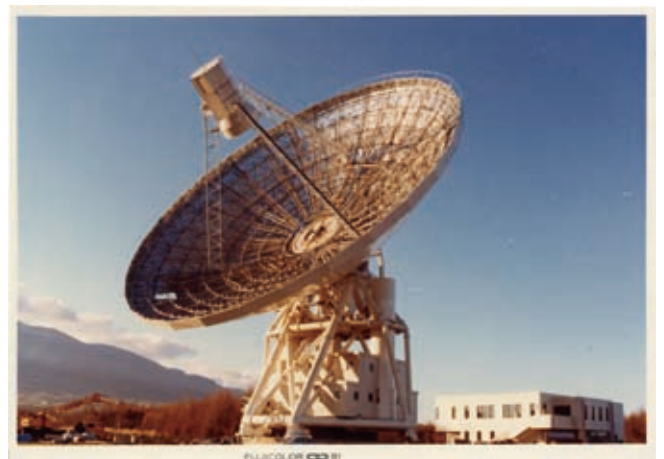
図3：建設中の45mミリ波望遠鏡。鏡面の反射パネルはまだ貼られていない。
