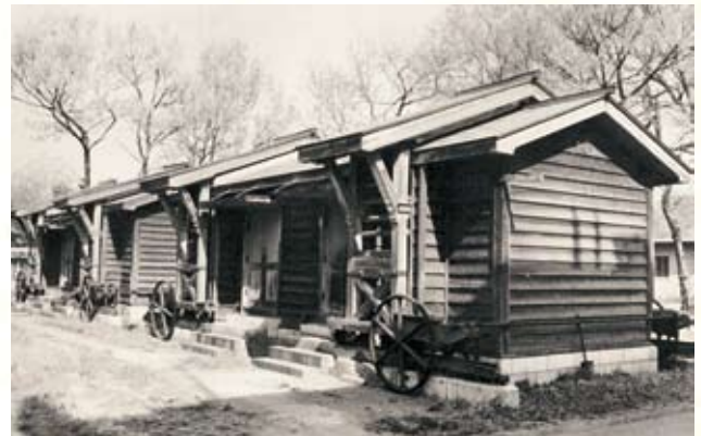
図2 時刻観測が行われた90 mmバンベルヒ子午儀が設置された聯合子午儀室。
