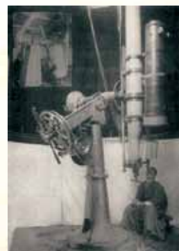
図4 ブラッシャー天体写真儀。トロートン・シムス望遠鏡に同架されている黒く短い鏡筒。現在は国立天文台天文機器資料館に展示されている (当連載で詳しく紹介の予定)。
