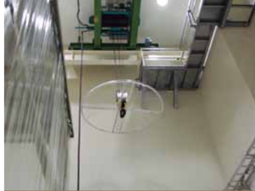
搬出入クレーン
