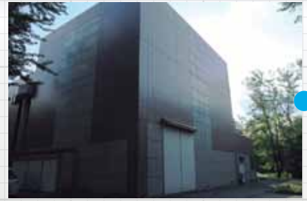
大クリーンルームへの搬出入口
