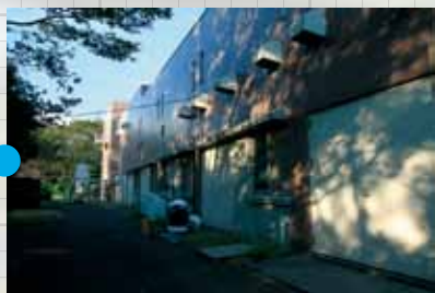
搬出入扉が並ぶ南棟裏
