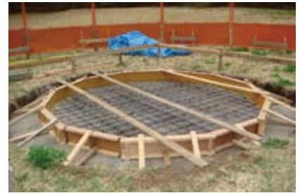
写真3 基礎工事とフェンス。
