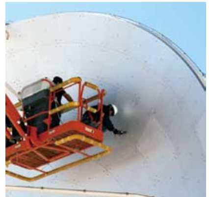
高い鏡面精度を達成するために、鏡面パネルは1ミクロン単位で調整可能なアジャスタに乗せられ、調整点のネジで微調整される。
