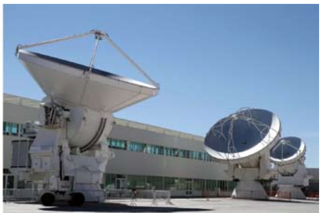
(左上画像) 日本が製作を担当する「いざよい」の7m(左)と12m(右)のアンテナ。(右上画像) 欧州の12m(左)と北米の12m(中)と日本の7m(右奥)のアンテナ。同じ12mアンテナでも、副鏡の支持アームの構造が、欧州は直棒、北米は取り付けが主鏡の縁まであり、日本はよりコンパクトな構造、とそれぞれ異なっている。
