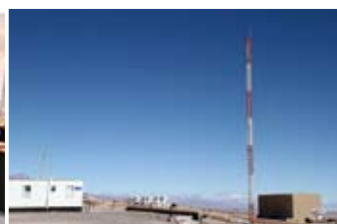
山麓施設内に立つ高い塔は、アルマの各アンテナの性能調整用の送信アンテナ。
