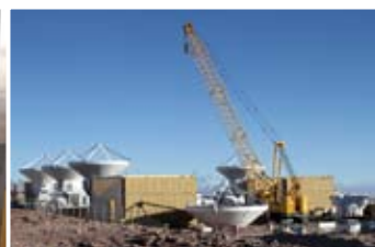
欧州（ESO）のアンテナ組み立てエリア。副鏡の支持アームが棒状であるところが特徴。
