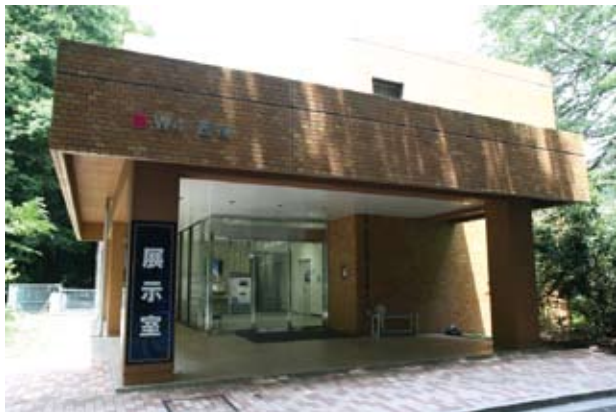
図1 新展示室は西棟1階です。旧子午環制御室の建物です。
