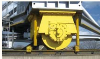
図2 浮き上がり防止機構の破断状況。爪から支持パイプがすべて抜けてしまった。
