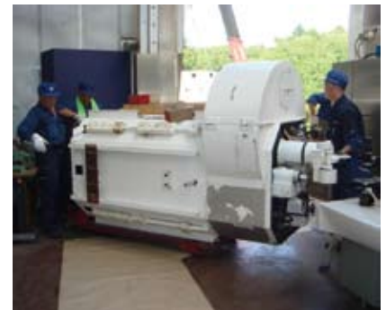
天文機器資料館への望遠鏡部分の吊り込み作業。
