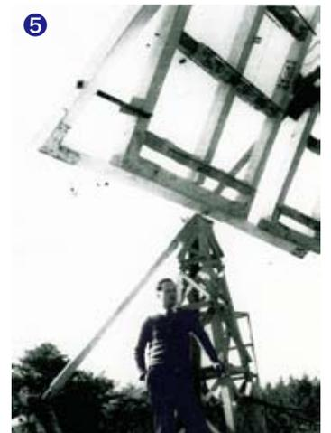
④三鷹で観測中の1号望遠鏡。1949年に設置。アンテナのフレームは木製。⑤日本の電波天文学を拓いた畑中武夫氏と1号望遠鏡。手作りの装置で試行錯誤を繰り返しながらの、文字通りゼロからの電波天文学のスタートだった。(写真提供/羽間フミ子さん)
