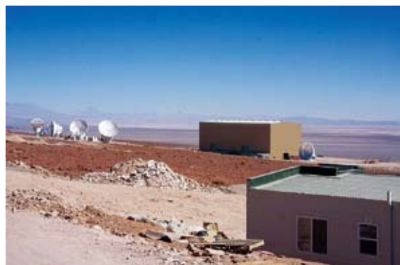
▲写真2：評価試験中の日米アンテナ群と宿舎（手前の建物）。
