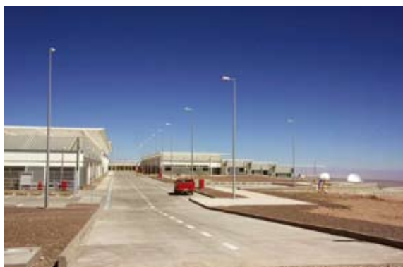
▲写真1：標高3000mで建設中のALMAの運用施設（右奥に見えるのは日本の12mアンテナ）。
