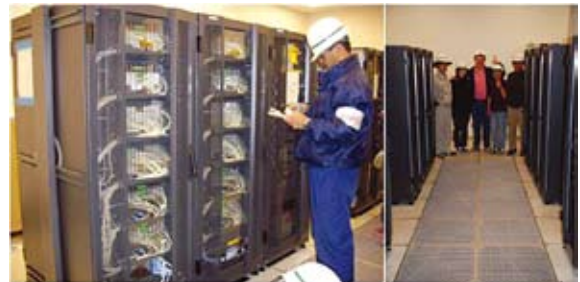
図7 ACA 関連器を標高 5000m 山頂施設に設置。
