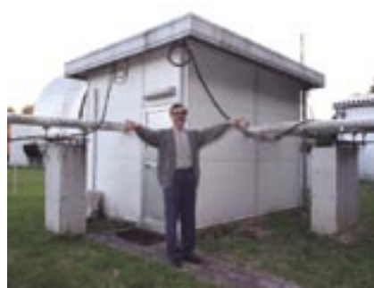
◀中央棟で南北ふたつの光路は、直角に曲げられて研究棟へ導かれる。光路パイプの中は真空だ。
