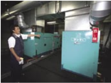
▲発電機は予備を含めた2機。「ドームを動かす瞬間に大電力が必要な特殊な使用環境なので、調整に気を遣います」。
